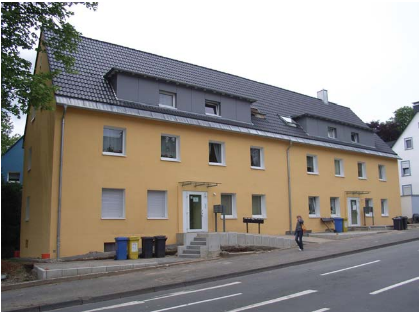
Sanierung Heresbachstraße 1 und 3
