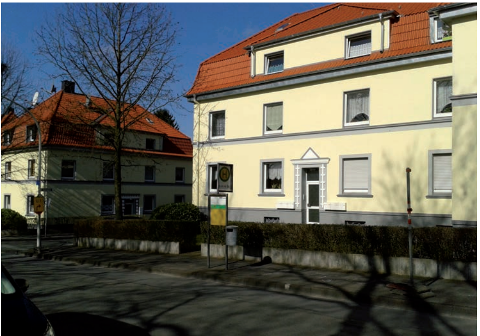
Dach und Fassadensanierung Altenhofer Str. 74
