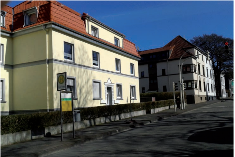
Dach und Fassadensanierung Altenhofer Str. 72
