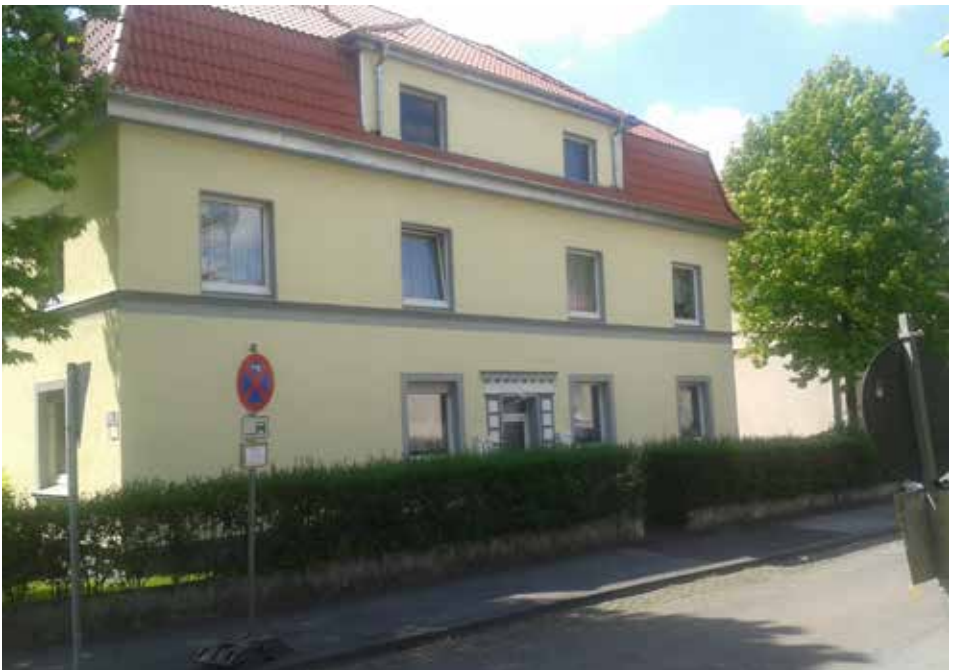
Fassaden- und Dachsanierung Rubensstr. 1
