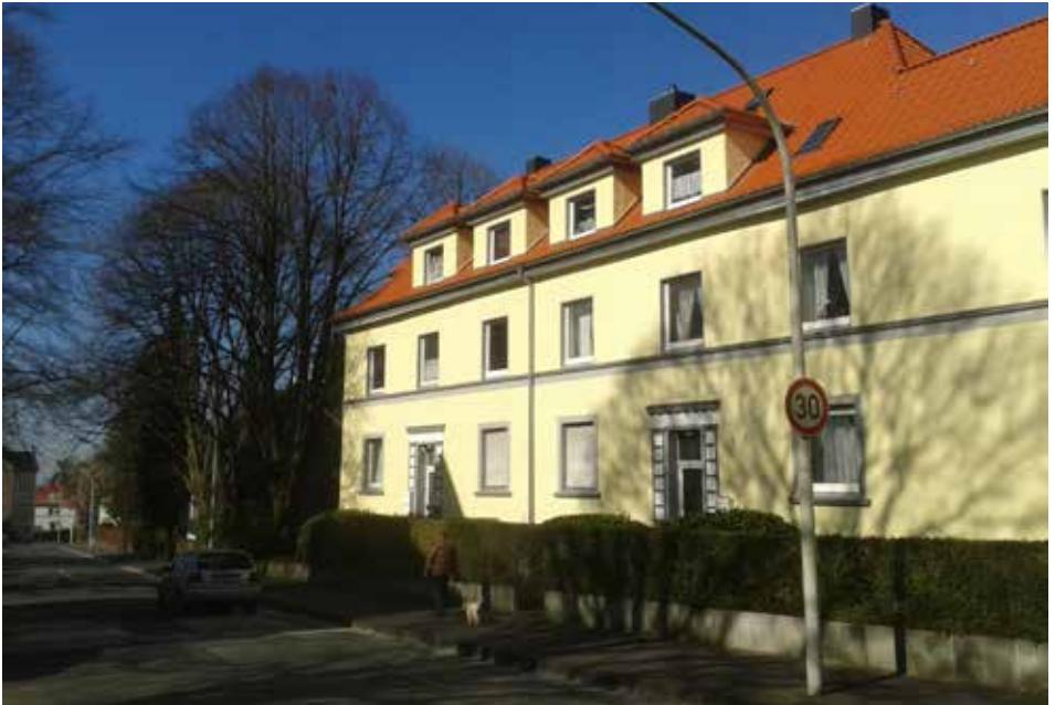
Fassaden- und Dachsanierung Altenhofer Str. 76 u. 78
