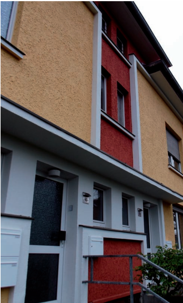
Dach- und Fassadensanierung Zeppelinstraße 34 – 40
