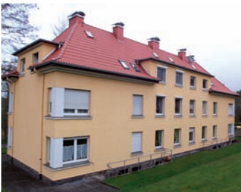
Dach- und Fassadenanierung Zeppelinstraße 34 – 40
