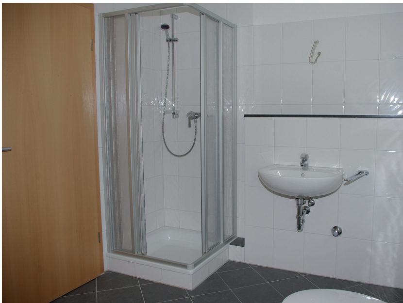
Dusche Bruckner Str. 74 nach Umbau
