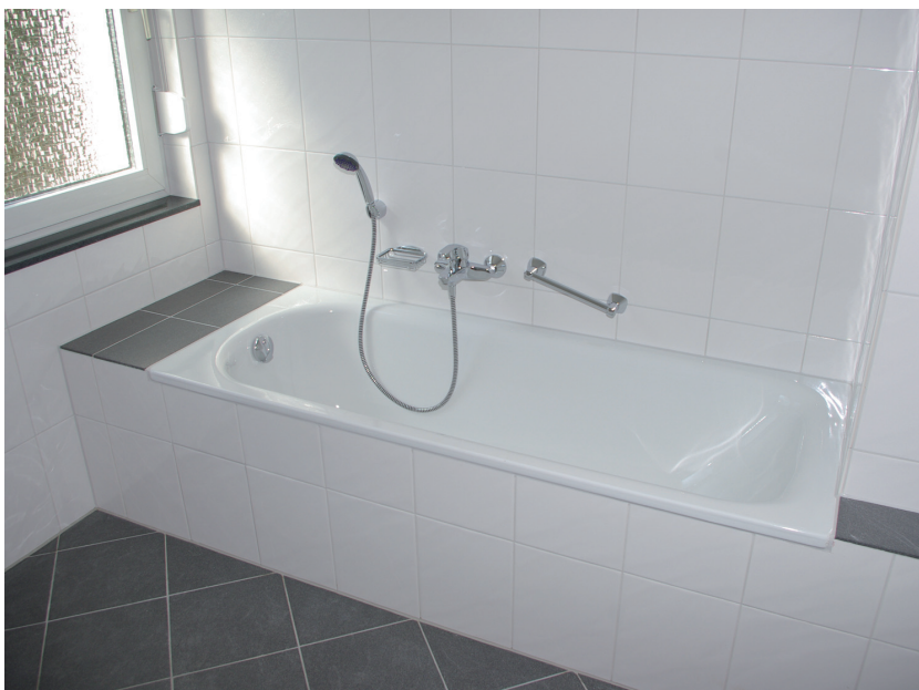
Bad Bruckner Str. 74 nach Umbau
