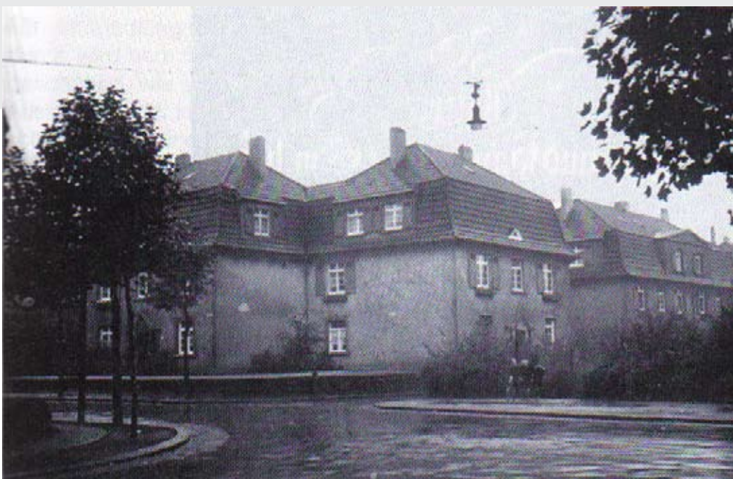
[Abb. 16] Von 1927 bis 1930 entsteht unter dem Architekten Walter Flabb am Frankenplatz und an den angrenzenden Straßen die Mustersiedlung der Genossenschaft (Aufnahme: 30er oder 40er Jahre)
