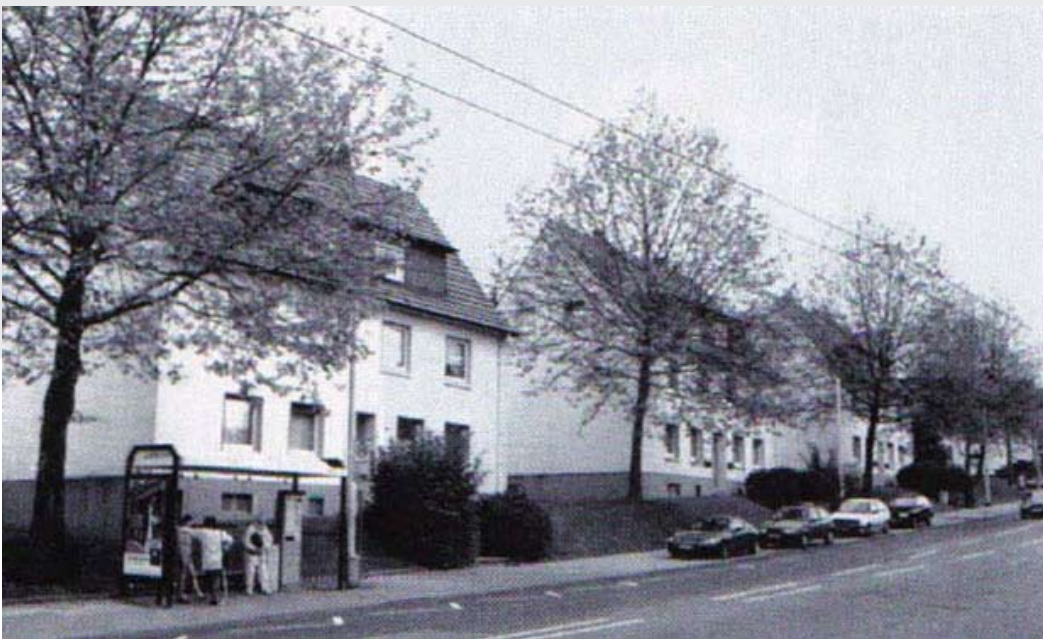
[Abb.22] Erste Neubauten nach dem Kriege aus den Jahren 1952/1953: Focher Straße Nr. 96-100 (Aufnahme 1997)
